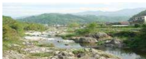
(松風橋(吊り橋)から観月橋、後方は岳八幡。)
